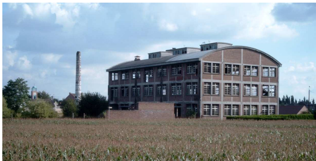
Le bâtiment Victoire et le cheminée, peu avant leur destruction
